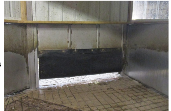
Puerta de goma con solapa; Las puertas deslizantes verticales construidas con una cortina flexible hecha de cintas transportadoras no dañarán a los cerdos si se cierran accidentalmente sobre ellos. Observe cómo el marco que se desliza en el riel se atornilla por encima de la cortina.
